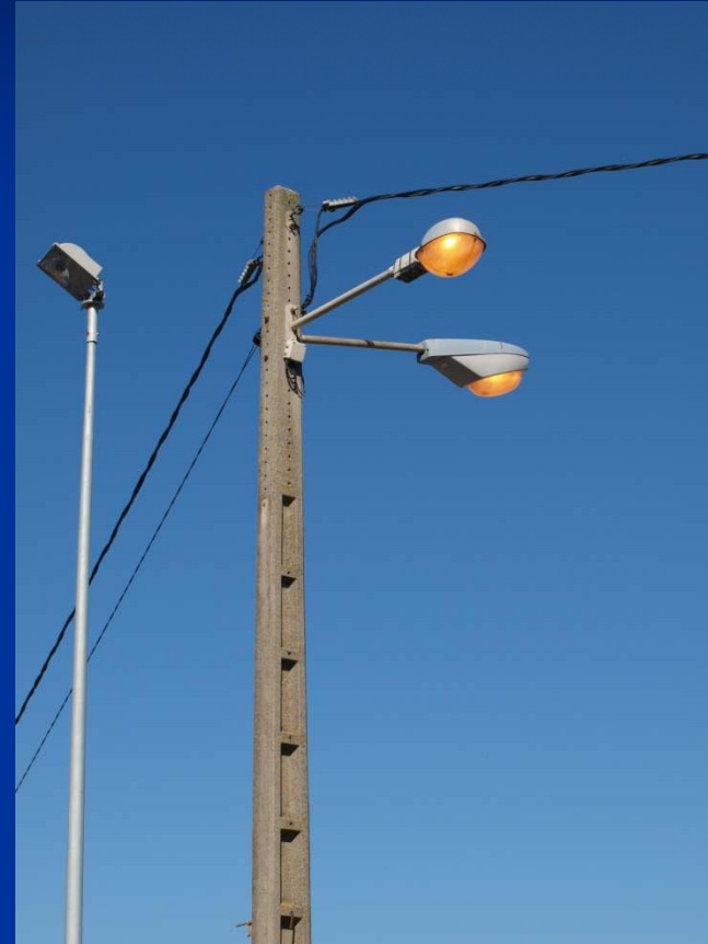
Alumbrado con el control por célula fotoeléctrica averiado
