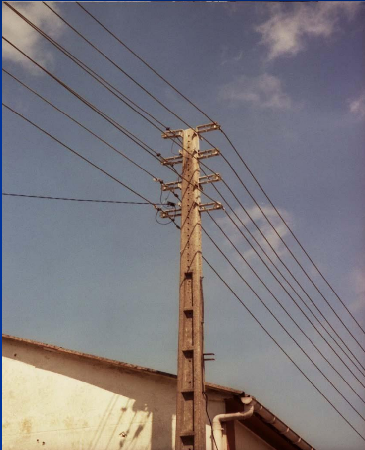
Apoyo con dos líneas (tres fases + neutro) de BT y una derivación con conductor aislado
