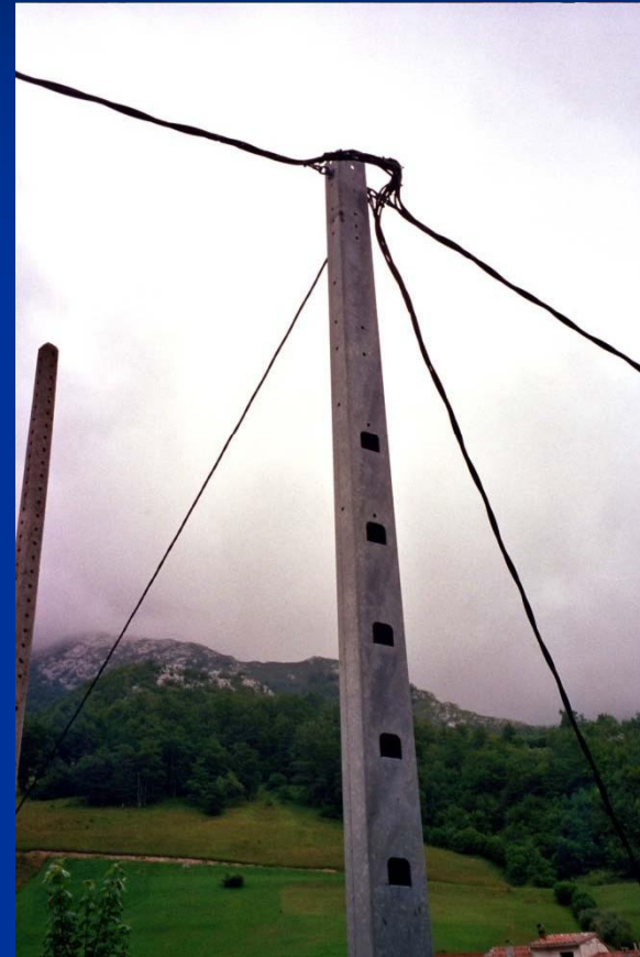
Apoyo de chapa metálica
