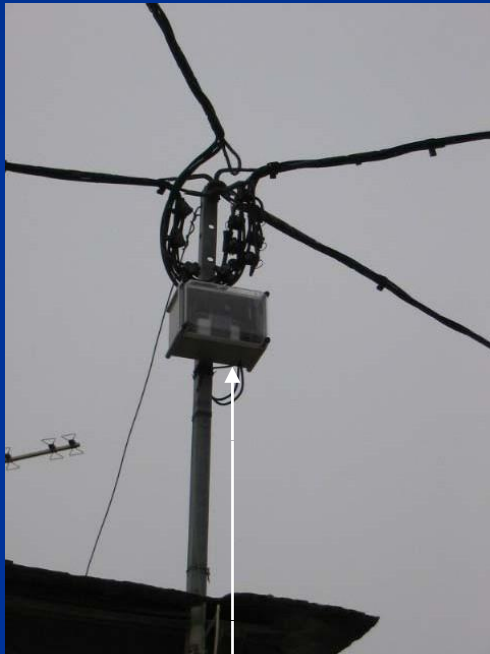
Autotransformador d
