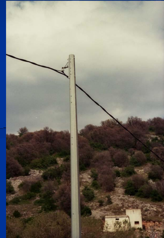
Apoyo de chapa metálica
